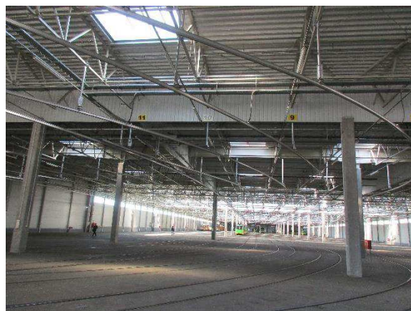
Obr. 2: Pevné trolejové vedení v hale vozovny
