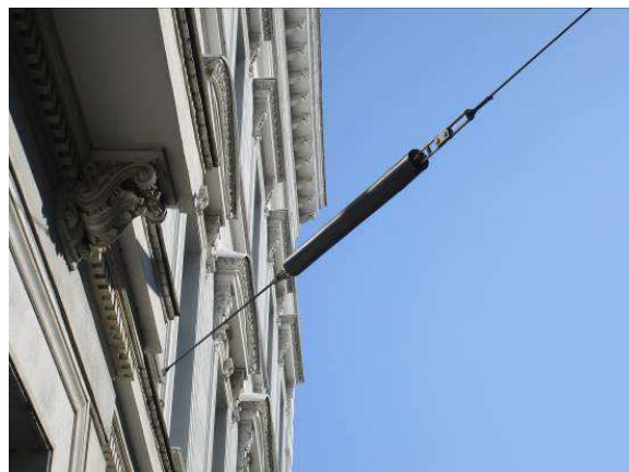
Obr. 16: Pružinový napínač
