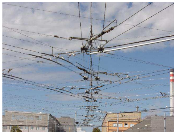
Obr. 34: Nosná síť výhybek ve vozovně
