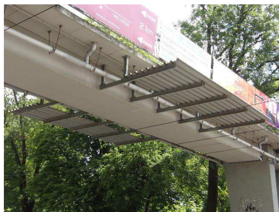
Obr. 26: Protidotykové zábrany upevněné na konstrukci mostu
