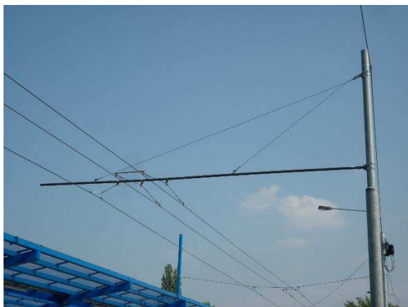
Obr. 5: Tramvajové a trolejbusové trolejové vedení na společném výložníku
