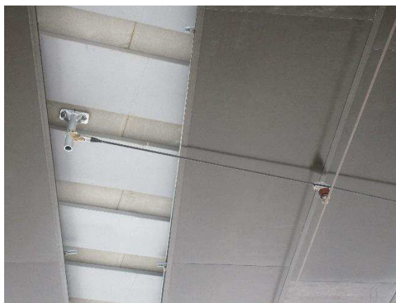
Obr. 67: Trakční vedení pod mostem
