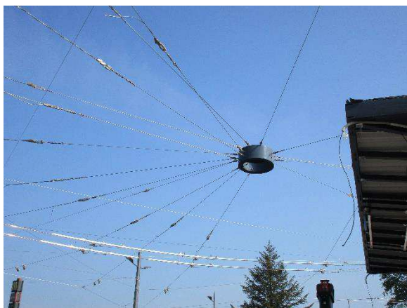
Obr. 74: Vytěšená obruč pro převěsy
