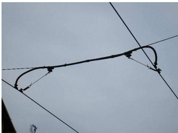
Obr. 53: Příčné propojení trolejí
