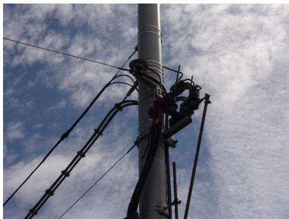
Obr. 46: Odpojovač U
