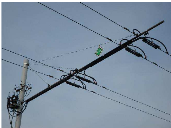
Obr. 51: Propojovací kabely na výložníku
