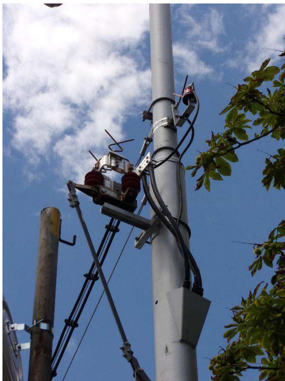
Obr. 49: Kabelový vývod uvnitř stožáru
