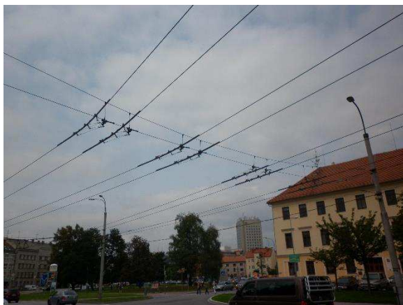
Obr. 19: Příčná řetězovka
