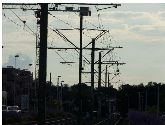
Obr. 8: Výměnný úsek řetězovkového vedení
