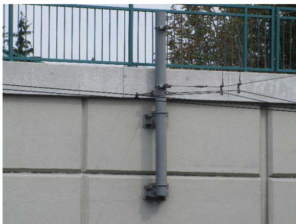
Obr. 72: Trakční vedení na zkráceném stožáru
