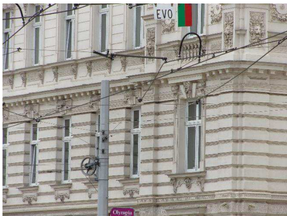
Obr. 9: Pevné kotvení prostého vedení
