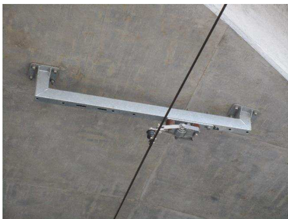
Obr. 66: Trakční vedení v podjezdu
