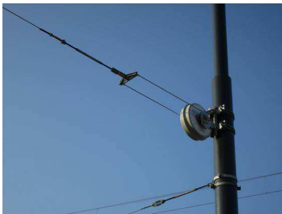
Obr. 15: Napínací zařízení Tensorex
