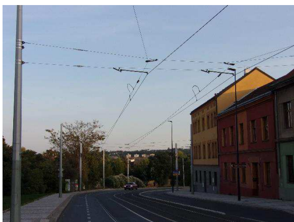
Obr. 7: Výměnný úsek prostého vedení
