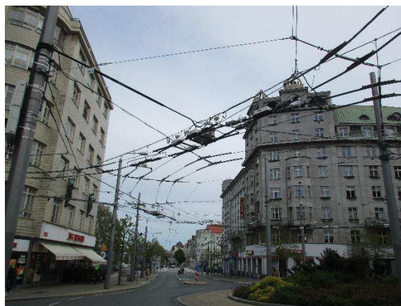
Obr. 24: Pevný trolejbusový závěs
