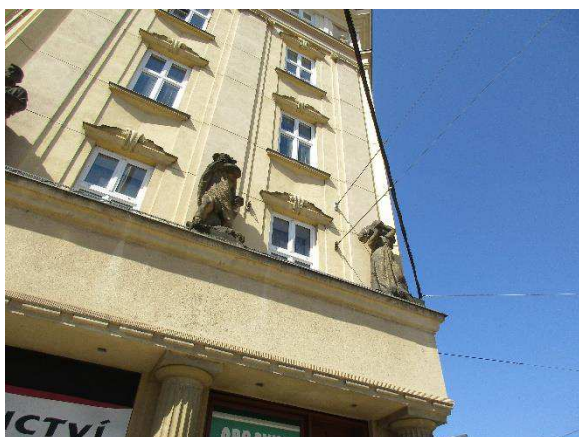
Obr. 62: Kotevní závěsy na fasádě budovy
