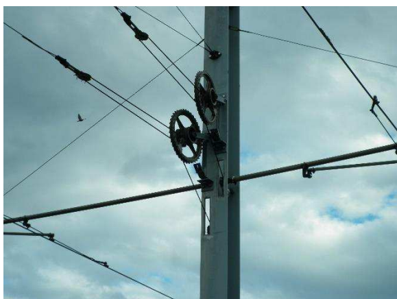
Obr. 13: Pohyblivé kotvení prostého vedení západkovým kladkostrojem v poměru 1:3
