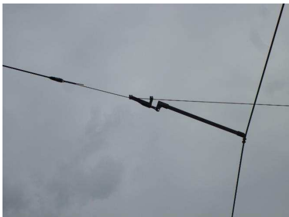
Obr. 21: Pružný tramvajový závěs
