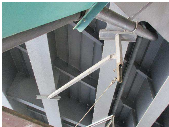
Obr. 65: Trakční vedení pod mostem
