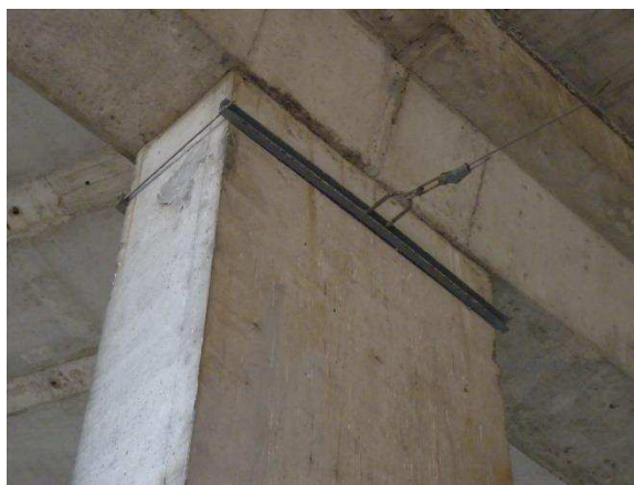
Obr. 73: Trakční vedení na mostním pilíři
