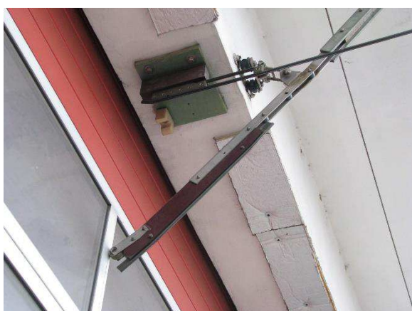
Obr. 27: Konstrukce sklopné troleje při spuštěných rolovacích vratech
