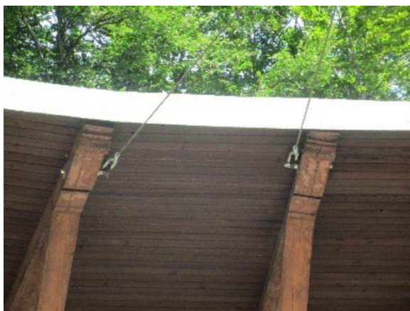
Obr. 68: Trakční vedení na dřevěné konstrukci
