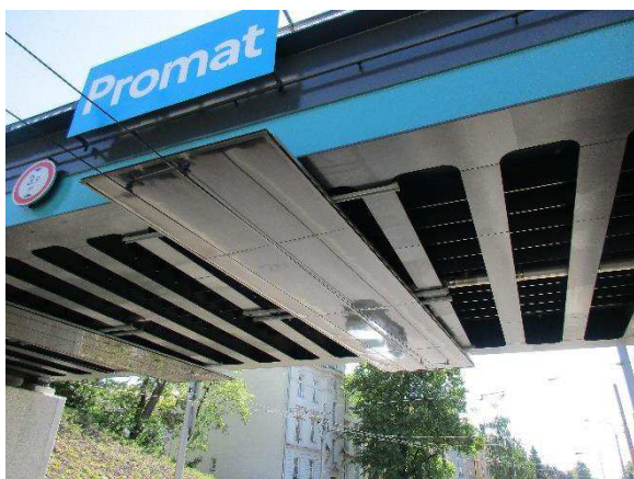
Obr. 25: Ochranné desky na nosné konstrukci pod železničním mostem
