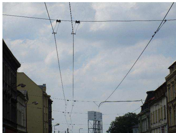
Obr. 6: Střídavé zavěšení trolejových závěsů na přímém úseku trolejbusové tratě
