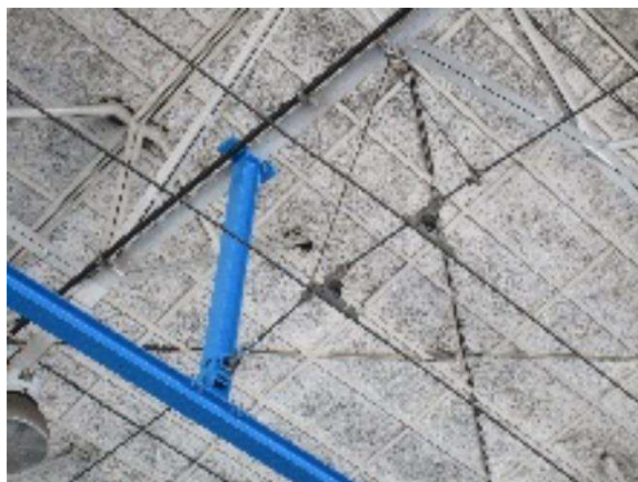
Obr. 71: Trakční vedení na nosné konstrukci budovy
