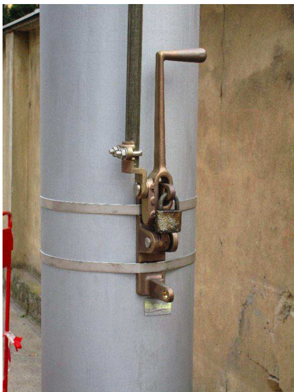
Obr. 47: Ruční pohon odpojovače
