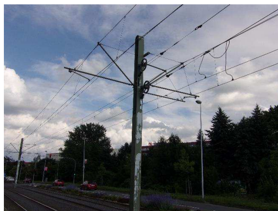
Obr. 14: Pohyblivé kotvení řetězovkového vedení západkovým kladkostrojem v poměru 1:3
